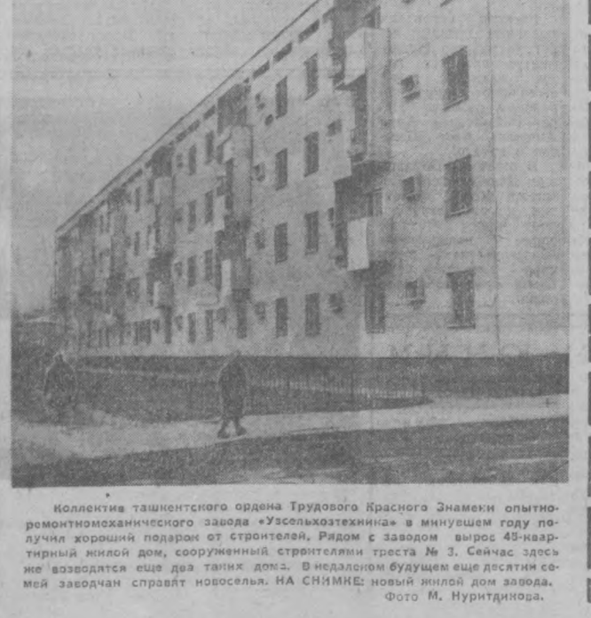
Коллектив ташкентского ордена Трудовой Славы института опытно-ремонтномеханического завода «Узелмехтехника» в минувшем году получил хороший подарок от строителей. Рядом с заводом вырос 45-этажный жилой дом, сооруженный строителями треста № 3. Сейчас здесь же возводятся еще два таких дома. В недалеком будущем еще десятком семей заводчан справят новоселье. НА СНИМКЕ: новый жилой дом завода. Фото М. Нуритдинова.
