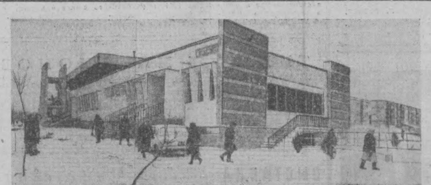
На снимке: общий вид нового комплекса обслуживания в микрорайоне А-3 массива Юусабад.
