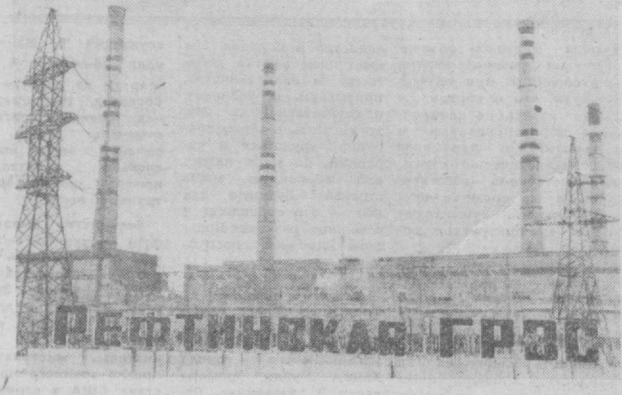
МОЩНОСТЬ УВЕЛИЧИВАЕТСЯ. СВЕРДЛОВСКАЯ ОБЛАСТЬ. Досрочно освоить последний, десятый энергоблок обласдал коллектив Рефтинской ГРЭС. С его пуском мощность станции достигла 3,8 миллиона киловатт. На предприятии намечены мероприятия, повышающие надежность оборудования, продолжа-
