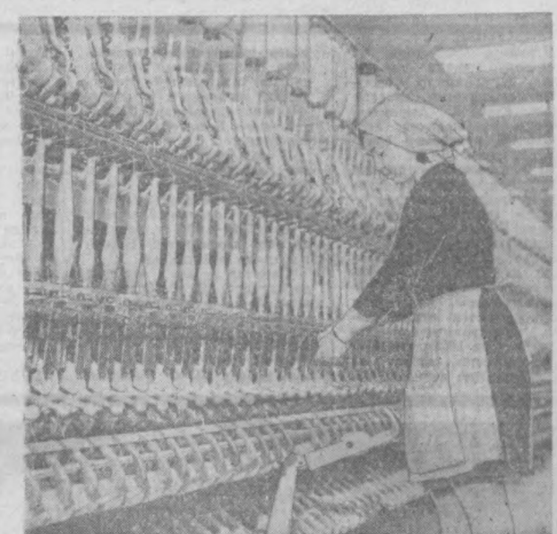
НАМАНГАНСКАЯ ОБЛАСТЬ. На одном из крупных текстильных объектов Средней Азии — Наманганском комбинате шелковых и костюмных тканей — горячая пора. Более 40 тысяч прядильных веретен обрабатывают прижу. Сейчас здесь ведется монтаж и пусконаладочные работы основного прядильного оборудования, прокрутки и заправки машин и агрегатов. Предприятие оснащается новейшим текстильным оборудованием. Проектная мощность комбината 65,5 миллиона метров шелковых и костюмных тканей в год. Здесь в основном трудятся комсомольцы и молодежь. НА СНИМКЕ: прядильница комсомолка Нелля Мингачева, она активная общественница, член штаба комсомольского прокатера, делегат городской комсомольской конференции. Фото В. Лейзеровича. (Фотохроника УэТАП).
