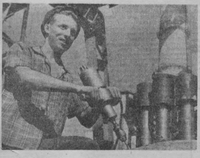
Коллектив монтажников ТашГРЭС обаялся закончить монтаж пятого турбогенератора в этом году.
