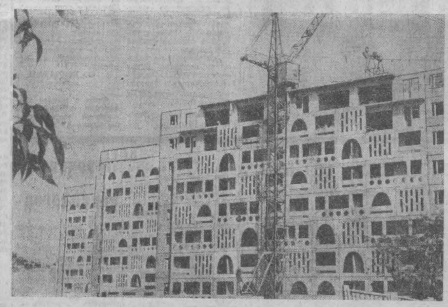
ТАШКЕНТ СТРОИТСЯ. Эти многоэтажные жилые дома возводятся на улице Богдана Хмельницкого. Они выделяются оригинальным оформлением фасадов.
