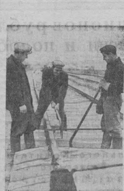
В РАЙОНЕ МИЛАНЗА-ГА ИДЕТ СТРОИТЕЛЬСТВО НОВОЙ ТРАМВАЙНОЙ ЛИНИИ. ЕЕ МАРШРУТ МУЖИКИ-СТАНЦИЯ
