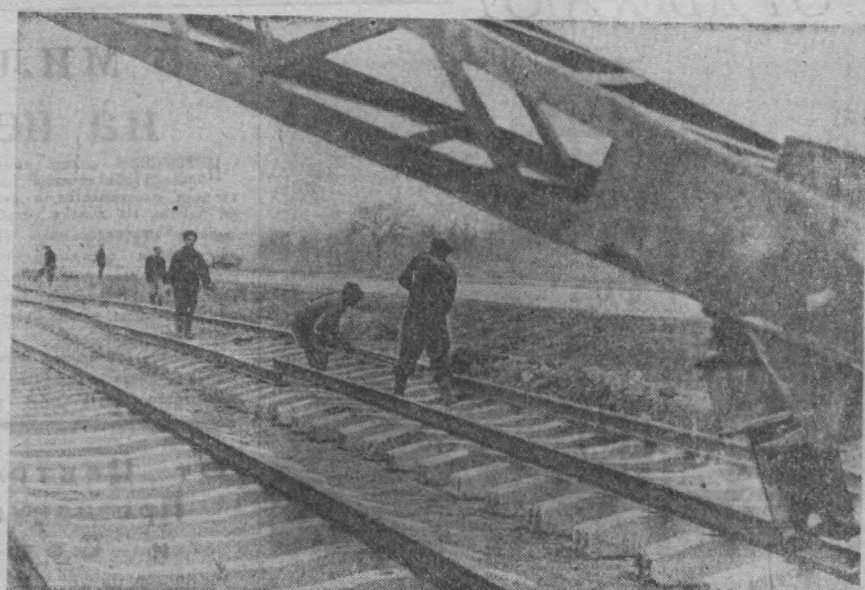
С. РАХИМОВА ПРОТЯЖЕНОСТЬЮ 7 КМ. СТРОИТЕЛЬСТВО НОВОЙ ТРАМВАЙНОЙ ЛИНИИ. ЕЕ МАРШРУТ МУЖИКИ-СТАНЦИЯ
