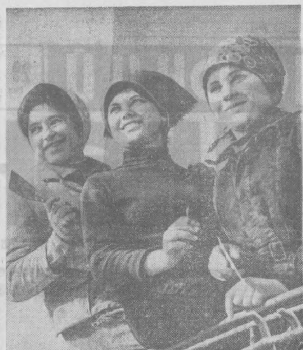
Из 15 городов Российской Федерации приехали в Ташкент строители. Посланцы из Новонизинки ведут строительство жилья в центре Ташкента.
