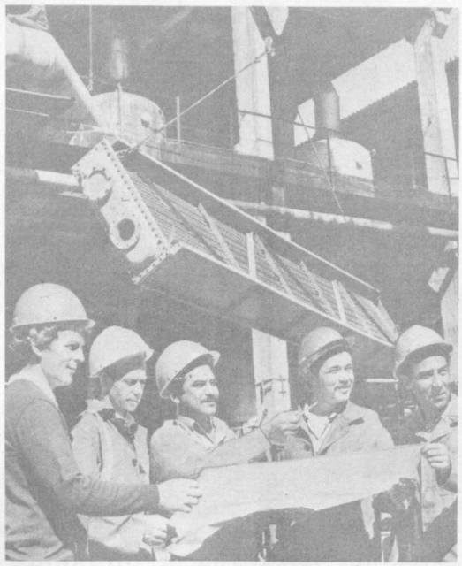
С опережением графика ведут работы на шестом блоке установки серосодержащих бригады Р. Исая и В. Пулюшкова РСУ Мубарекского газоперерабатывающего завода. Пересмотрев свои обязательства, они решили на два дня раньше завершить ремонт оборудования. А это значит, что потребители дополнительно получат более 1.000 тонн серы и два миллиона кубометров «голубого топлива».
