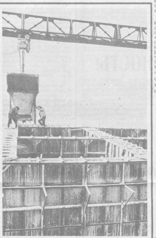
КАШКАДАРЬСКАЯ ОБЛАСТЬ. На полтора месяца раньше срока сдан 13 коттеджей в совхозе «Ленин юлы» Каршинского района строители межхозяйственной передельной механизированной колонны № 241 треста «Облагропромстрой». Оперативно справиться с заданием им помог новый метод строительства. С этого года строители возводят четырех-, пятикомнатные сейсмостойкие коттеджи из монолитного керамзитобетона. Стоимость строительства относительно невысока.
