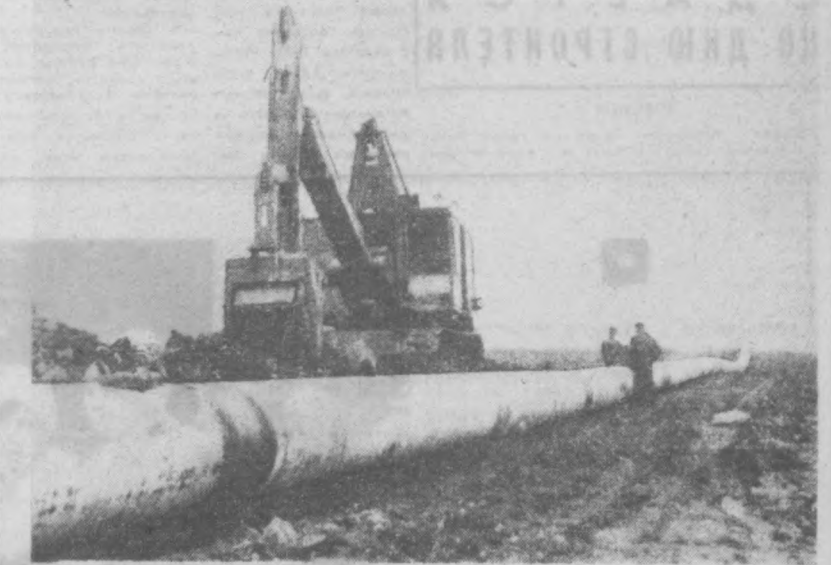
Близится к завершению сооружение второй очереди чехословацкого участка нефтепровода «Дружба». Эта новая магистраль протяженностью 450 километров соединит Западный Словению с Северной Чехией. Сейчас строители в честь 50-летия Великого Октября взяли обязательство завершить годовую план к 12 декабря. Дню подписания Советско-Чехословацкого договора о дружбе и экономическом сотрудничестве.
