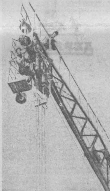
Авария! Лопнул наметочный трос. Но вот через два часа подъемный кран вновь заработал, и строительство жилого дома не приостановилось.
