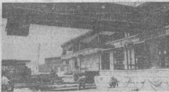
На фото вы видите цех-полигон завода ЖБИ-1. Цех выпускает и изготавливает плиты для жилых домов. На переднем плане, идет заготовка новой плиты, а наверху — мостовым транспортом заготовленные формы укладываются в пропарочную камеру. На последнем плане идет погрузка плит предприятия для жилых домов строящегося города Ташкента.
