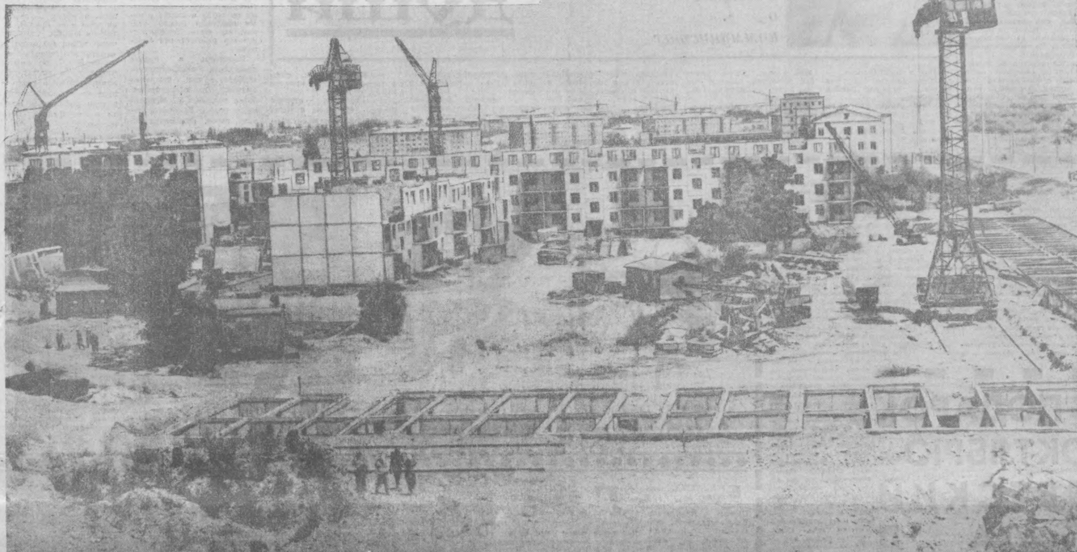
ЖИЛОЙ МАССИВ ЧЕРДАНЦЕВ. ВОЗВОДЯТ СТРОИТЕЛИ ТИВАТШКЕНТСТРОЯ. ИДЕТ СТРОИТЕЛЬСТВО В СЧЕТ 2-ГО МИЛЛИОНА КВАДРАТ. МЕТРОВ ЖИЛОЙ ПЛОЩАДИ.
