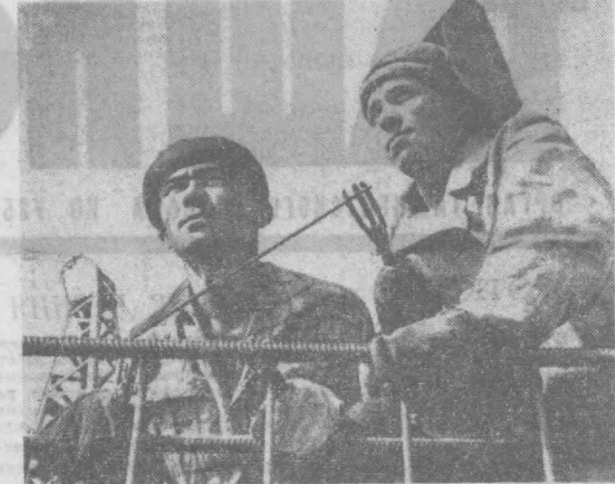
Строители-электросварщики Н. Гагеев (справа) и Наби Юлдашев приехали из Новокузнецка на восстановление нашей столицы. Вместе со своими товарищами они возводят новые дома в центре Ташкента. Сейчас новоконные строители работают на строительстве четырех- и девятиэтажных домов. Фото А. Тураева.
