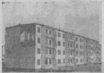
Стоит на 17-м квартале Чиланзара дом, мало чем отличающийся от рядов стоящих зданий. И только надпись на фасаде говорит о том, что Ташкентский домостроительный комбинат вложил в него свой миллионный квадратный метр жилой площади. Построенный руками строителей Главташкентстроя, он готов принять жителей города. В КИСЕЛЕВ. Фото автора.
