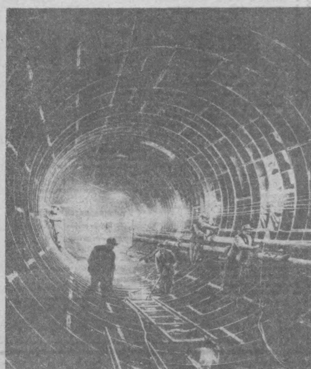
БУДАПЕШТ. Венгерская столица строит новые современные линии метрополитена. НА СНИМКЕ: работы в тоннеле, продолженном под улицей Раноци. Фото МТИ—ТАСС.
