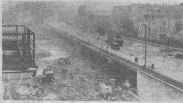
МОСКВА. Садовое кольцо становится скоростной трассой. Вскоре откроется движение по третьей, самой крупной эстакаде кольца — по Самойловой площади. НА СНИМКЕ: на строительстве эстакады. Фото Н. Грановского. Фотохроника ТАСС.
