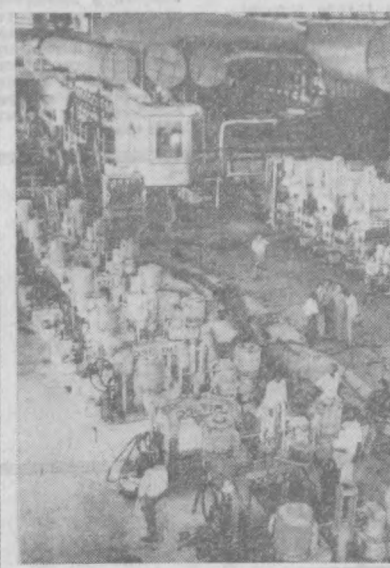
ИНДИЯ. Проволочный стан «250» на Бхиялском металлургическом заводе, построенном с помощью Советского Союза.
