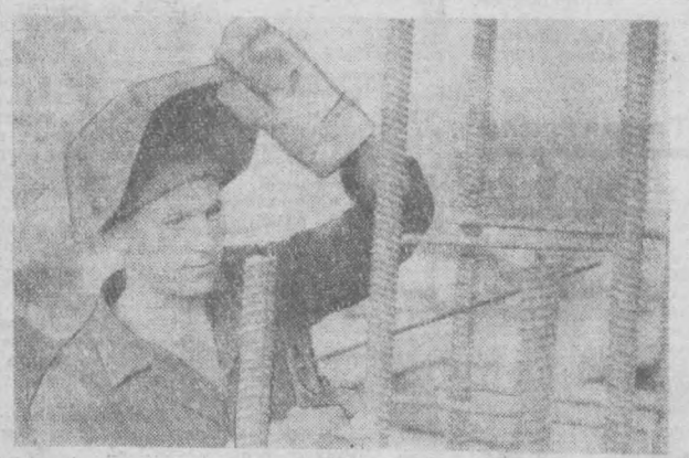
Тянутся высь арматуры новых этажей в квартале Ц-4. Вот почему так настойчиво и внимательно осматривает каждый шов электросварщик Александр Васильевич Коряков. Работа должна быть безупрочной! Александр Васильевич из Волгограда. Не один дом пришлось построить ему в городе мужества на Волге, а теперь вот он здесь, в нашем городе, возводит многоэтажные дома, все время перевыполняя задания. Фото И. Алеева.
