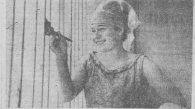
Весело бежит малярная кисть по деревянным рейкам балкона вверх, вниз и снова вверх... Минна Бурасова довольна: ровно ложится краска, балкон будет просто загляденье!
