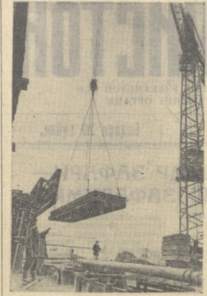
Андинда темир-бетон конструкциялари яғиғандан оғик полигон қурилмоқда. Полигон қурилиши тамомлангандан кейин яғиға 90 минг кубометр яғиға темир-бетон беради. Суратда: полигон қурилишида.
