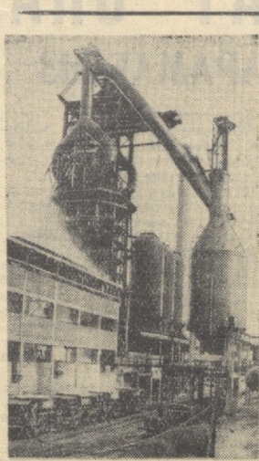
Суратда: Пекин металлургия комбинатининг 3-домна печи.
