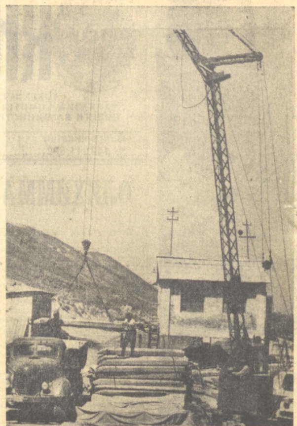
ЎЗБЕКИСТОН ССР кишлоқ хўжалиги министри энергетика бошқармасига қарашли Андижон электромеханика устанонаси колхоз ва совхозларни электрлаштириш учун зарур бўлган темир-бетон гуллар қиғирмоқда. СУРАТДА: устанона полигонидан тайёр гуллар жўнатиламоқда. Л. Мейнерт фотоси, (ЎзТАГ фотокорреспонденти).
