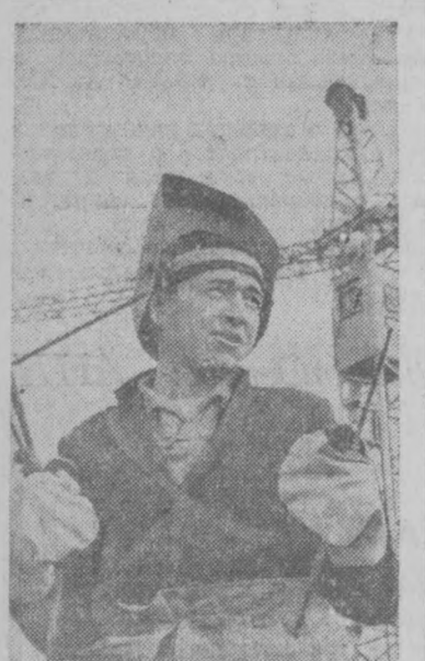
Строитель нового Ташкента ленинградец 7-го строительного участка монтажник В. С. Крылов. Фото А. Тураева.
