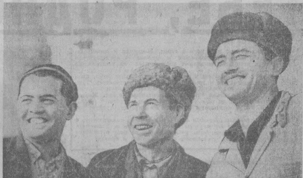
Строители Ленинадского домостроительного комбината подготовили к сдаче два сорокачетырехквартирных дома. Это отличный новогодний подарок ташкентцам. НА СНИМКЕ (слева направо): передовик шофер Ш. Низамитдинов, электросварщик П. Карепанов и бульдозерист Ш. Хасанов. Фото М. Нуритдинова.
