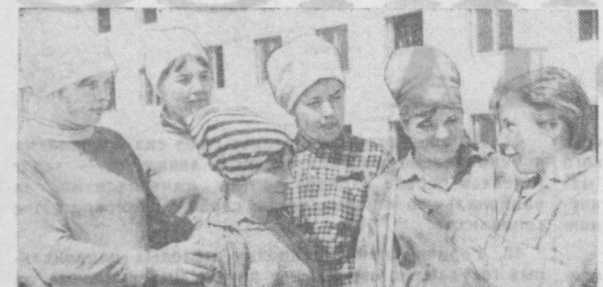
Бригада штукатуров-отделочников, возглавляемая Анной Репренцевой является одной из передовых. Отделочники этой бригады систематически перевыполняют все задания при хорошем качестве.
