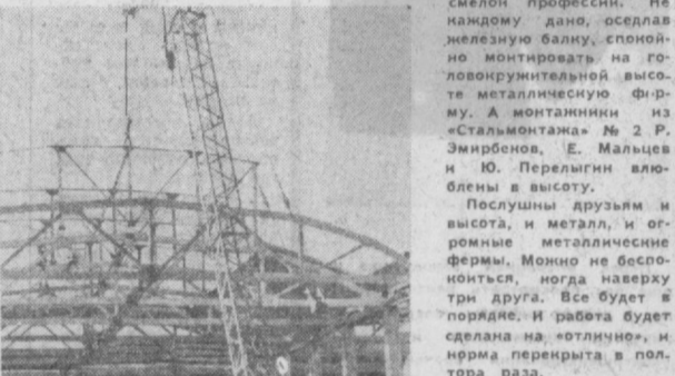
Сейчас монтажники трудятся на строительстве производственных корпусов ремонтно-механического завода № 1 «Стройиндустрии». На верхнем снимке: монтажники (слева направо) Р. Эмирбеков, Е. Мальцев и Ю. Перельгин.
