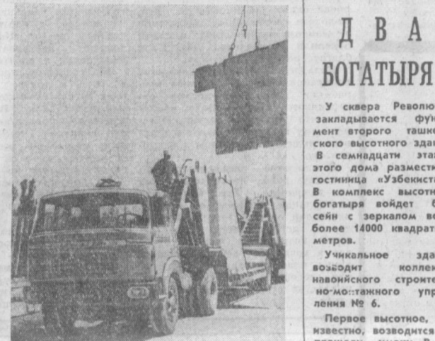
Учальное здание возводит коллектив навоийского строительного-монтажного управления № 6.
