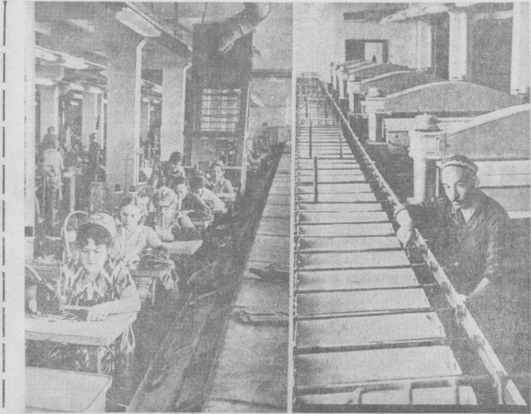
В новой промышленной зоне Чиланзарского района завершаются строительные и монтажные работы по оборудованию новой обувной фабрики № 2. Предприятие ежегодно будет изготавливать три миллиона мужской и женской модальной обуви.
