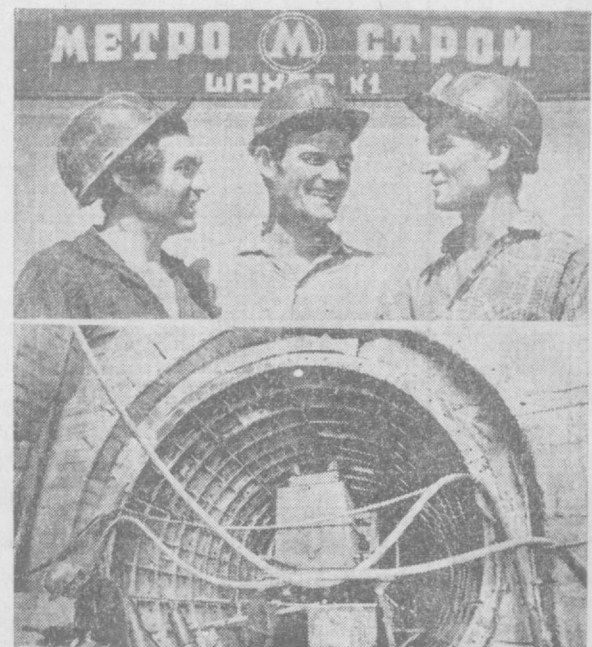
Широкий фронт ведут работы по сооружению Ташкентского метро. Между станциями Фархадская и Дуслани тоннель протяженностью 1,800 метров пробивает бригада проходчиков, руководимая И. Морозовым. Колонны решки пробить тоннель из этого участка сплотившимся методом — за девять месяцев. НА СНИМКЕ сверху — проходчики участка № 1 станции Фархадская Станислав Попов, Евгений Ачмасов, Владимир Швецов. Внизу — проходческий щит в тоннеле. Фото И. Глауберсона и В. Сироткина.
