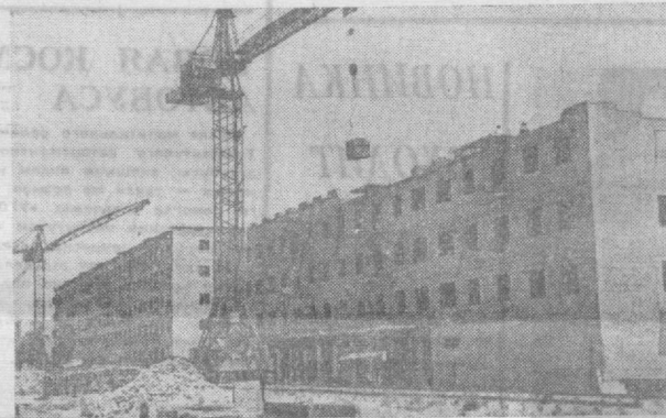
Здесь возводятся новые жилые дома. Работы ведет строительный трест № 4 Главташкентстрой.
