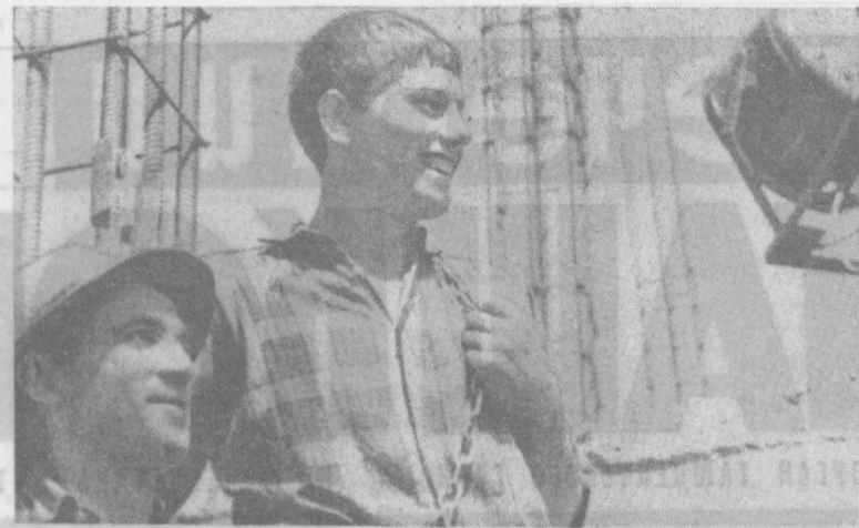
ИЗ ДНЕПРОПЕТРОВСКА ПРИЕХАЛИ В ТАШКЕНТ МОНТАЖНИКИ ВАСИЛИЯ МУДРИЧЕНКО (ЗВЕНЬЕВО) И АЛЕКСАНДР СИДОРЕНКО. В МИКРОРАЙОНЕ «УКРАИНА» ОНИ СТРОЯТ 9-ЭТАЖНЫЙ ЖИЛОН ДОМ НА 200 КВАРТИР.
