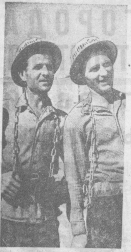
ЕВГЕНИЯ МАЛЬЦЕВ И ЮРИА ПЕРЕЛЕГИН — ПЕРВООБЫЕ МОНТАЖНИКИ ТРЕСТА «СТАЛЬМОНТАШ-2».
