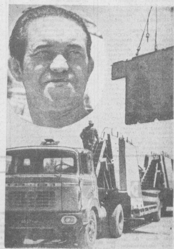
ТАШКЕНТСКИЙ ДОМОСТРОИТЕЛЬНЫЙ КОМБИНАТ № 1. Непрерывным потоком отсюда идут панели на строительные участки города. НА СНИМКЕ: Момент загрузки панелевоза. Сверху (в круге) один из лучших машинистов башенного крана Р. Камалев. Фото М. Нуритдинова.
