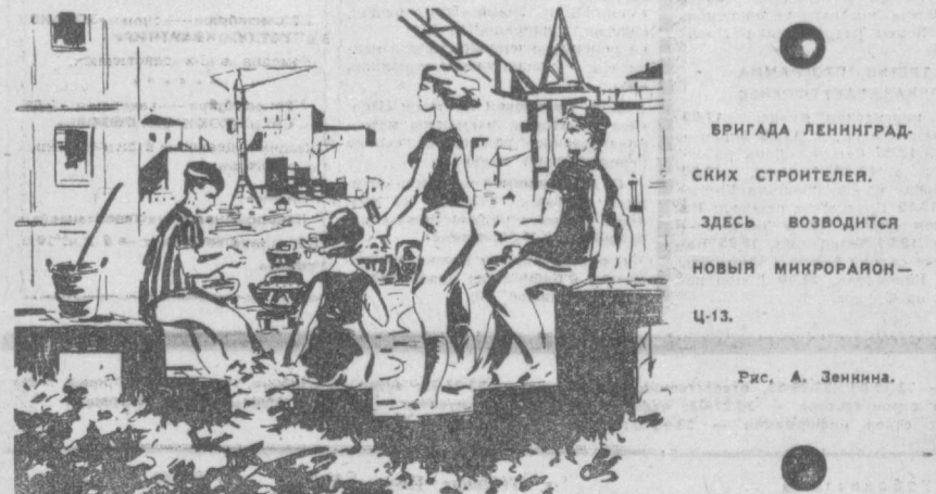
БРИГАДА ЛЕНИНГРАДСКИХ СТРОИТЕЛЕЙ. ЗДЕСЬ ВОЗВОДИТСЯ НОВАЯ МИКРОРАЙОН — 4-13. Рис. А. Землина.
