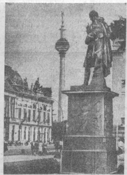
НА СНИМКЕ: Берлин. Строится новая телебашня. Фото А. Глауберсона.
