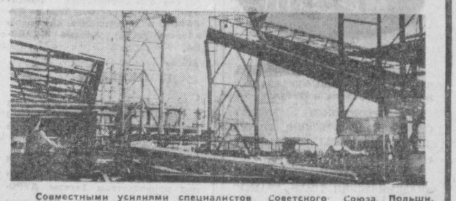
В совместными усилиями специалистов Советского Союза, Польши, Венгрии и ГДР близ Лейпцига на базе бурого угля сооружается крупная тепловая электростанция, на которой будут установлены турбины мощностью по 200.000 киловатт. Первый ток должен поступить в энергосеть Германской Демократической Республики 1 сентября 1969 года. НА СНИМКЕ: строительство электростанции «Тирбах». Фото АДН — ТАСС.
