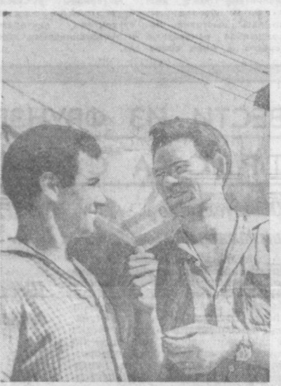
Успешно трудятся на строительстве музея имени Ленина передовые механизаторы — машинисты экскаваторов Ганс Зичанов и Виктор Мулюкин. Они за смену вынимают до 300—800 кубических метров грунта. Работают передовые строители в управлении механизации № 2 треста № 2.
