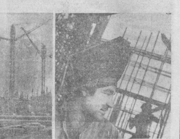
НА СНИМКАХ: (слева) — идет строительство первого в Узбекистане 19-этажного административного здания. Отлично трудятся здесь бригада арматурщиков Виктора Сухого и бригада бетонщиков Талдыбаева Сулейманова; (справа) — передовая арматурщица из бригады Виктора Сухого СУ-1 треста «Высострой-11» Юрий Асладжон. Фото О. Цоя.
