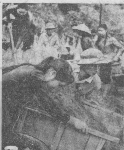
ДЕМОКРАТИЧЕСКАЯ РЕСПУБЛИКА ВЬЕТНАМ. Этот снимок сделан на участке строительства новой автострады, где трудится ударная молодежная бригада «571». Преодолевая трудности, молодые строители систематически перевыполняют нормы дневной выработки. Фото ВИА—ТАСС.
