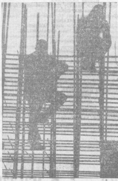
НА ТАШКЕНТСКОЙ НОВОСТРОЙКЕ. Фото О. Цоя.
