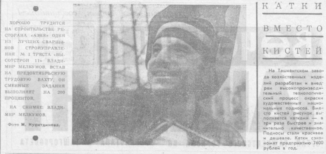
Хорошо трудится на строительстве ре- сторана «Азия» один из лучших сварщиков СТРОЙУПРАВЛЕНИЯ № 1 ТРЕСТА «ВЫСОТСТРОЙ» ВЛАДИМИР МЕЛКУМОВ. ВСТАВ НА ПРЕДЭКТАВЕРСКОМУ ТРУДОВОЮ ВАХТУ, ОН СМЕННОЕ ЗАДАНИЕ ВЫПОЛНИЛ НА 200 ПРОЦЕНТОВ.
