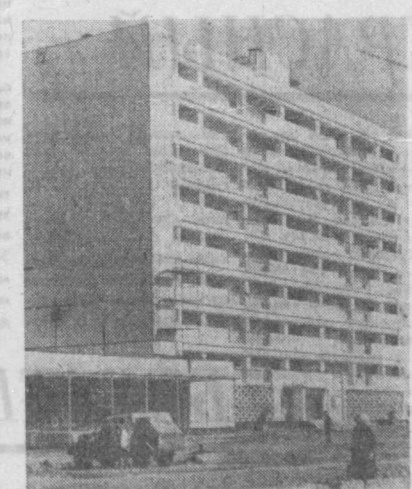
ЧИЛАНЗАР, КВАРТАЛ В-23. НОВЫЙ 9-ЭТАЖНЫЙ ЖИЛОЙ ДОМ НА 56 КВАРТИР. ЕГО ВОЗВЕЛИ СТРОИТЕЛИ ПОДМОСКОВЬЯ.
