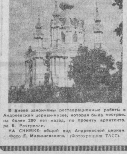
В Кичее закончены реставрационные работы в Андреевской церкви-музее, которая была построена более 200 лет назад, по проекту архитектора Б. Растрелли. НА СНИМКЕ: общий вид Андреевской церкви. Фото Е. Малишевского. (Фотохроника ТАСС).
