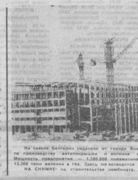
На севере Болгарии недалеко от города Видин строится комбинат по производству автоприцепов и вагонов из полиамидных смол. Мощность предприятия — 1,200,000 пневматических автоприцепов и 13,200 тонн вагонов в год. Здесь же возводятся электростанции. НА СНИМКЕ: на строительстве комбината. Фото БТА-АПН.
