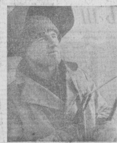
НА СНИМКЕ: сварщик арматурщик треста «Сибстальконструкция» Иван Моталыгин. Он трудится на строительстве 9-этажного жилого дома в микрорайоне Ц-5. Две нормы в день — такова его выработка. Фото М. Нуриддинова.
