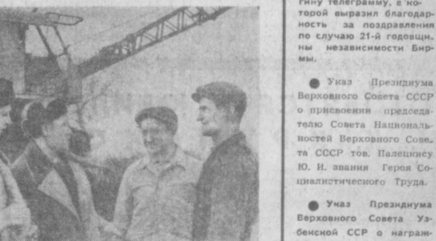
В Анжуйском и Янгйульском районах ведет ирригационные работы передвижная механизированная колонна № 2 треста «Ташмелиоводстрой». Здесь хорошо трудятся механизаторы Н. Иванченко, Н. Паршин, Р. Мильхерт, А. Ревенко (на снимке слева направо). Фото В. Ломоцева.
