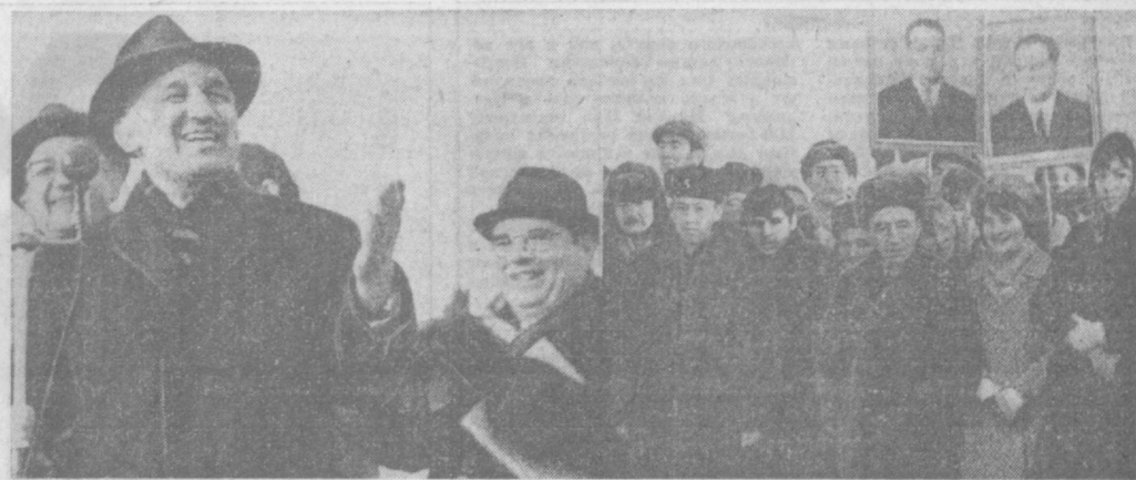
Митинг, посвященный закладке фундамента здания будущей школы. Выступает товарищ Тодор Живков. Фото М. Нуритдинова.
