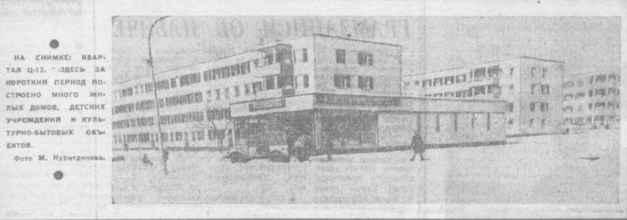
НА СНИМКЕ: КВАРТАЛ Ц-13. —ЗДЕСЬ ЗА Короткий период построено много жилых домов, детских учреждений и культурно-бытовых объектов. Фото М. Нуритдинова.
